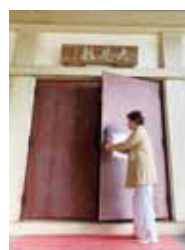
重い防災扉を参拝者 が自ら開けて入ります。 中には更にガラス 格子戸があります。
