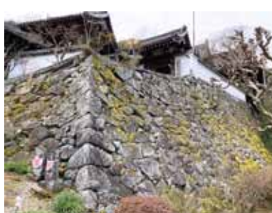
きれいに積み上げられた石垣の上に建っ ています。
