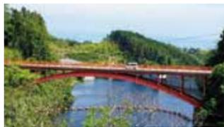
開運橋(文化庁登録有形文化財) 全長106mの銅製橋。昭和6年竣工で「上路カンチレバー橋」という形式です。現存する最も古い橋とされています。橋から開運バンジーというバンジージャンプを体験することができます。
