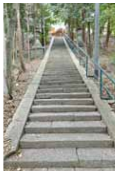
拝殿前の階段 古墳の後円部への階 段になります。
