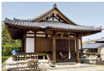
嘶堂(いななきどう) 本堂の裏手にあり、天平秘仏・木造馬頭観音立像が安置されています。一般的な頭部に乗せられた「馬頭」がないお姿で、怒りの表情をされているのが特徴です。
