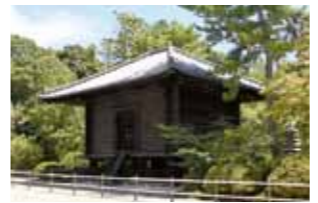
宝蔵(奈良時代) 正倉院より古い最古の校倉造りで大変貴重な存在だそうです。
