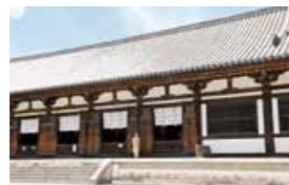
講堂(国宝・奈良時代・入母屋造・本瓦葺) 本尊弥勒如来坐像(重要文化財・鎌倉時代)。建物は平城宮にあった建物を移築されたものです。
