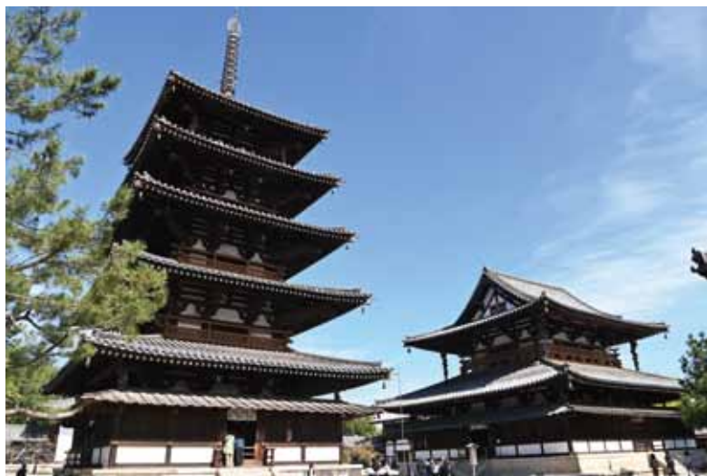
法隆寺のシンボル五重の塔（飛鳥時代）、高さは約 32.5m、 金堂（飛鳥時代）と共に世界最古の木造建築。
